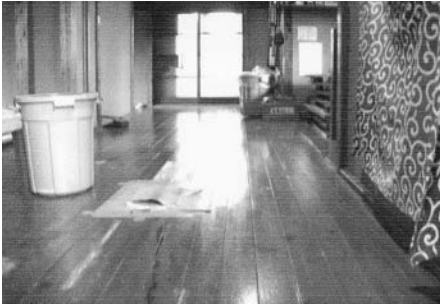
写真2 同窓会館2階 渡り廊下。右側トイレは使用できず、戸は無くなり、風呂敷で仕切られている。床には穴があき、ガムテープで補修している。
